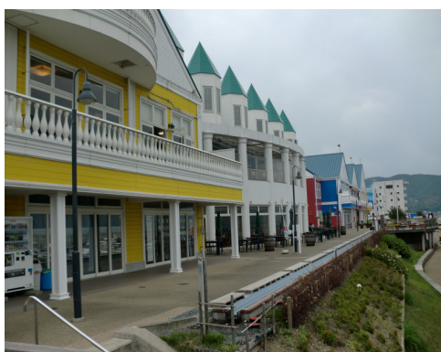
建物の玄関は海側(右)、道路側は裏こなる
