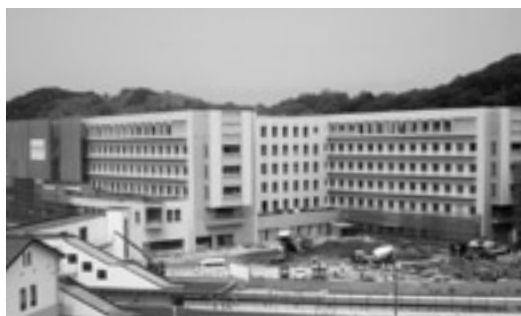
浜田医療センター工事風景（6月上旬現在）
