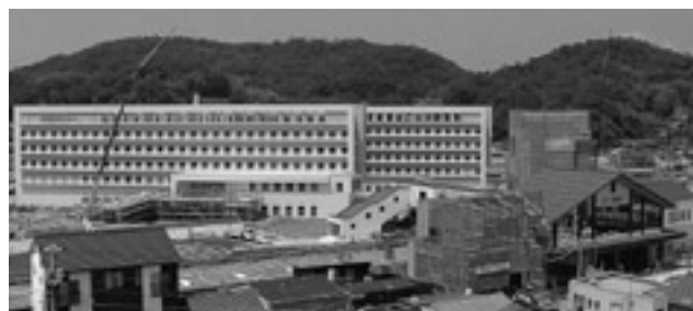
浜田医療センター工事風景（8月上旬現在）
