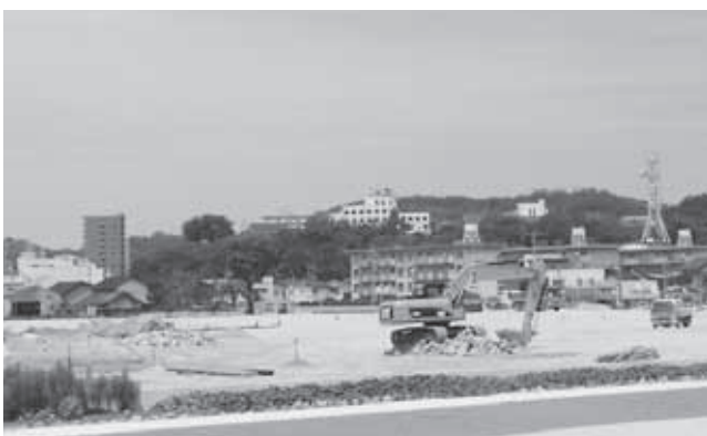
着々と工事が進む建設現場
