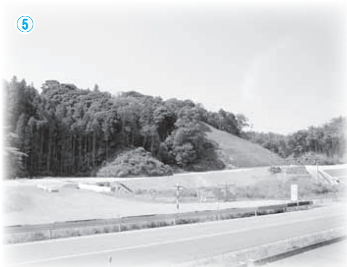
三隅IC（仮称）出口付近（平成24年6月撮影）
