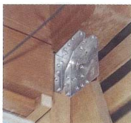
接合部の補強 (柱と梁の接合部の補強)
