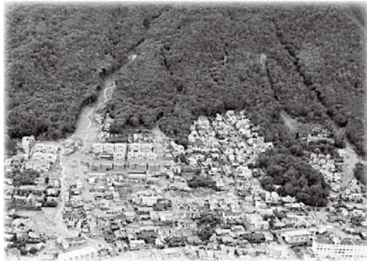
昨年8月に発生した広島土砂災害（安佐南区八木地区）の様子
