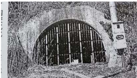
松原試掘坑口
