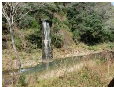
有福第四トンネル出口橋脚
