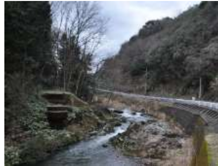
現在の写真。手前の橋脚は失われており、水面付近に土台跡と鉄筋がわずかに残っている。
