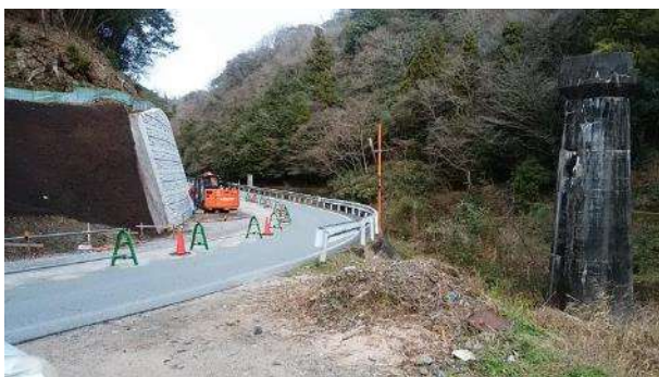
県道工事現場
