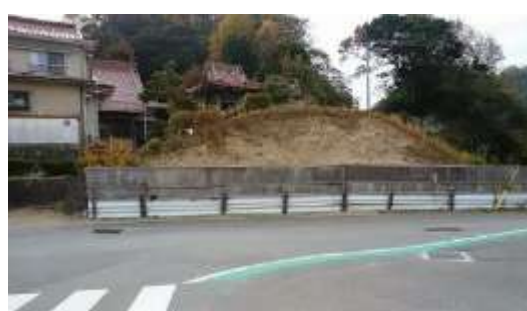
下府橋梁撤去後
