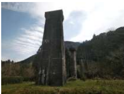
下で見る橋脚群
