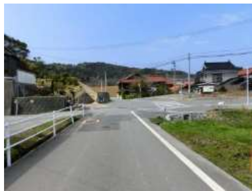
下府橋梁撤去後
