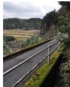
現在の様子。市道に転用されており、橋の両側に落下防止のための手すりが設置されている。
