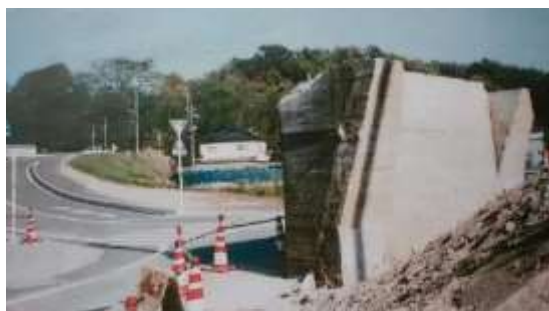
下府橋梁撤去工事中
