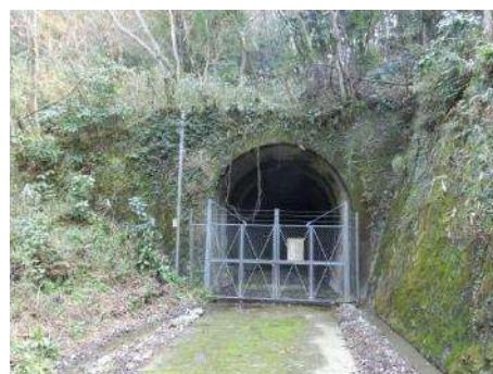
上府第二トンネル
