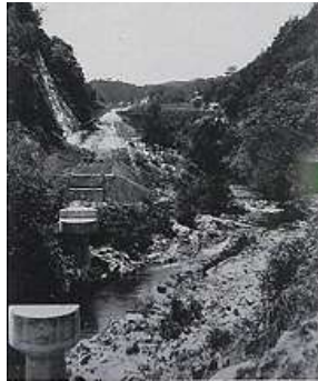
昭和14年頃の写真。今福第五トンネルを抜け下府川を渡る工事現場で、まっすぐ佐野地区へ路盤が伸びている。
