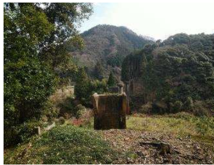
上から見る橋脚群
