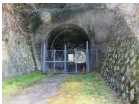
上府第一トンネル
