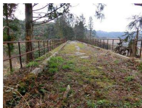
寺廻橋梁上部
