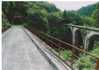
新線・旧線の橋梁
