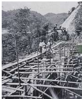
昭和13年頃の建設中の写真。当時は杉の丸太を使って足場を組んでいた様子がわかる。
