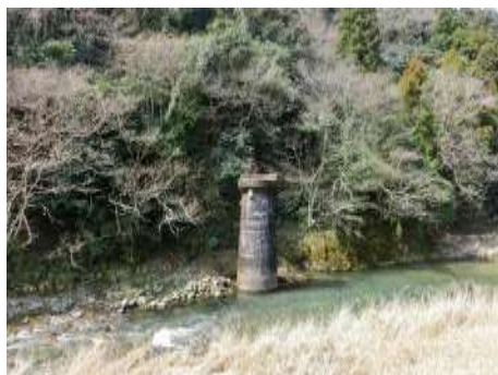
有福第三トンネル出口橋脚
