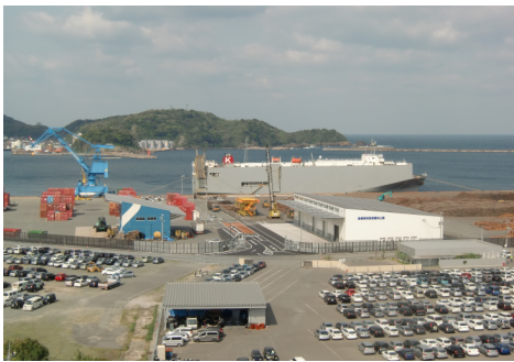
浜田港（福井地区）
