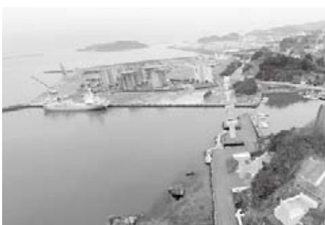
建設中の臨港道路福井4号線
