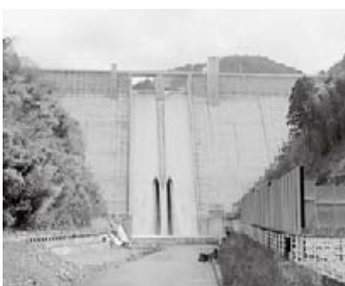
第二浜田ダム
