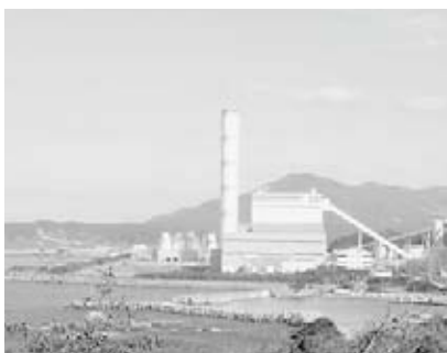
中国電力三隅発電所
