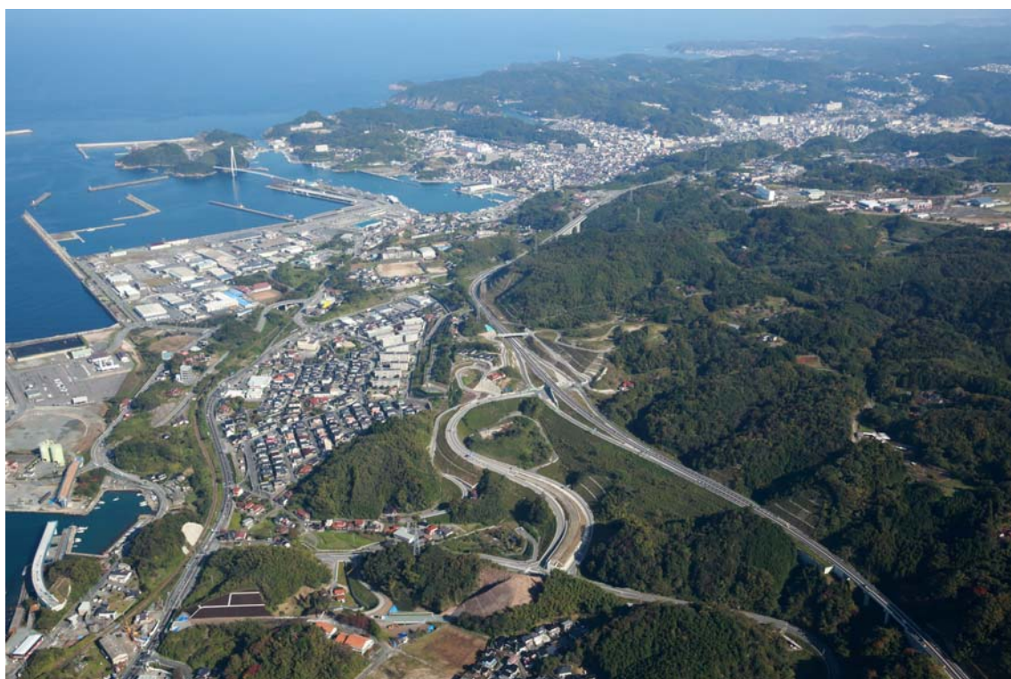
山陰道浜田・三隅道路(平成28年12月18日全線開通)
