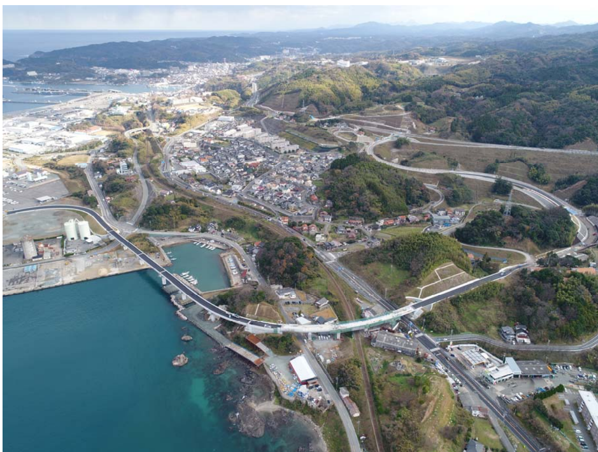
臨港道路福井4号線(平成30年春供用予定)
