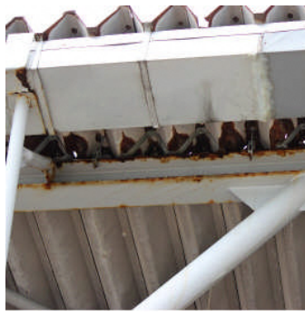
腐食が進む屋根（3号上屋）
