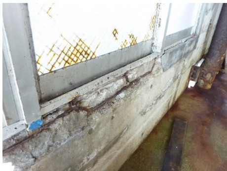
ブロック壁面の破損（2号上屋）
