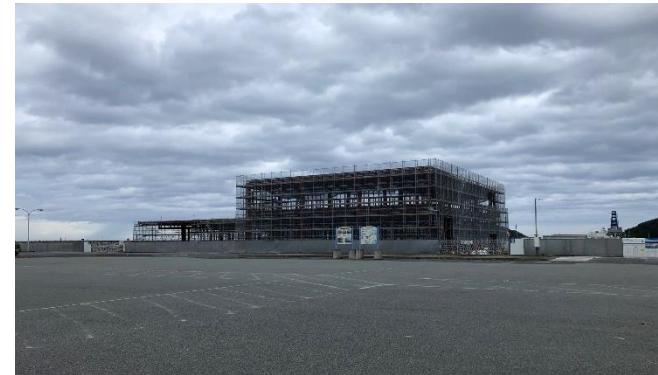
施工状況 (R1.8.15)
