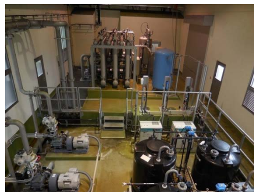
新戸川浄水場
