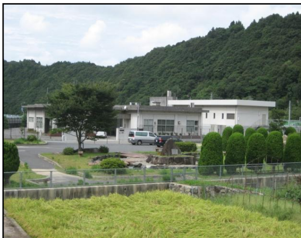
写真3 美川浄水場 昭和45年建設
