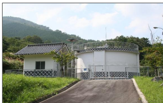
写真5 坂本峠配水池（旧新旭簡易水道事業）
