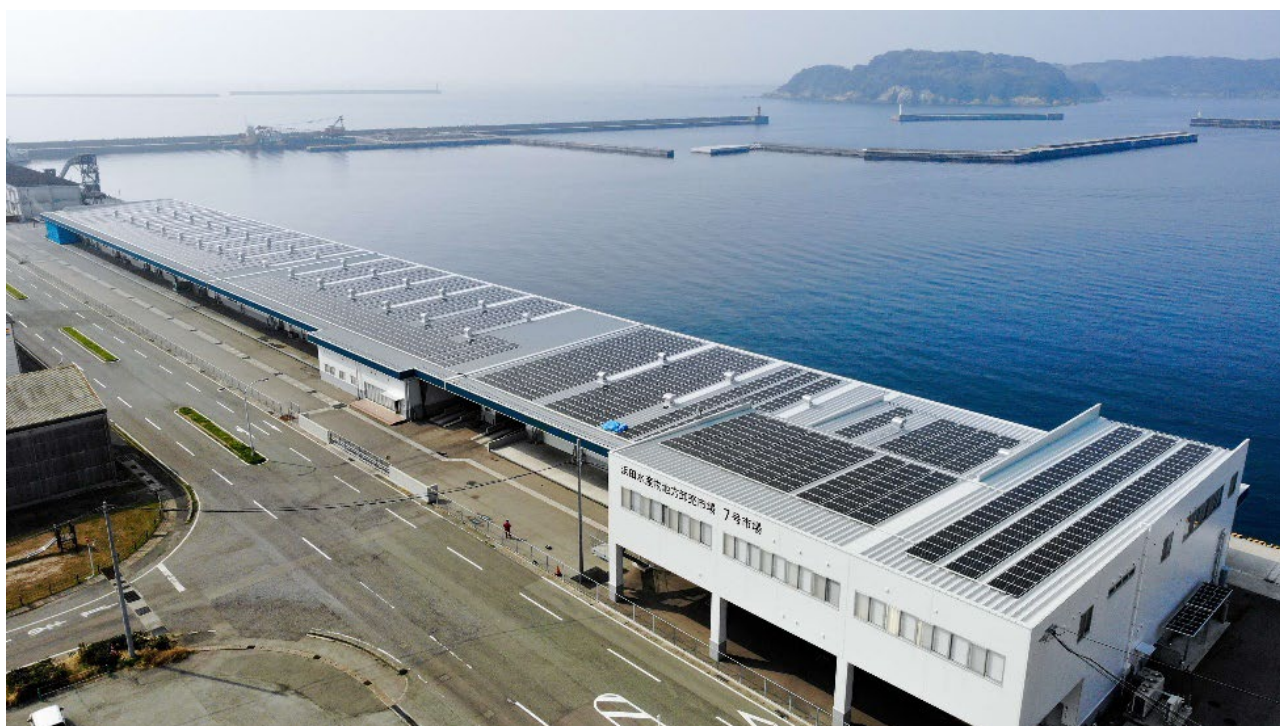
浜田漁港高度衛生管理型 7 号荷さばき所太陽光発電所
