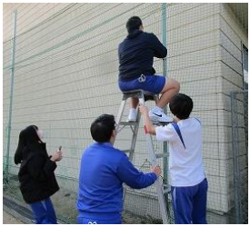
防球ネットの補修
