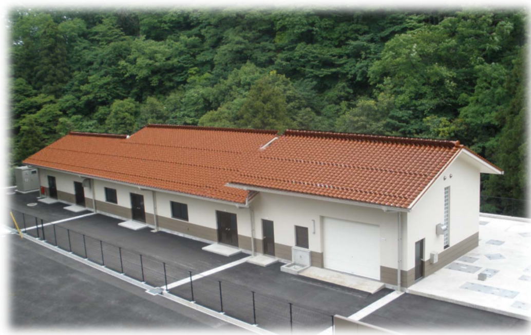
【雲城地区污水处理場】
