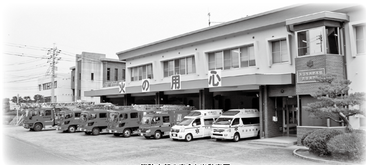
消防本部の庁舎と出動車両
