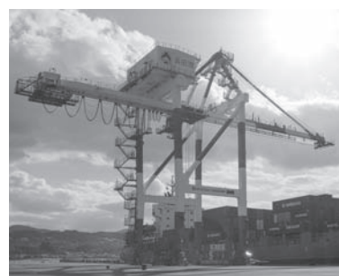
1月に供用を開始した浜田港福井埠頭のガントリークレーン
