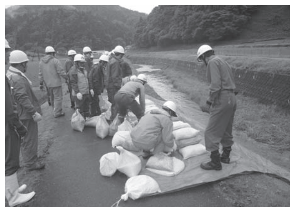
消防団による土のう積み上げ
