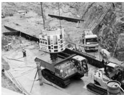
「第二浜田ダム」本体コンクリート初打設
