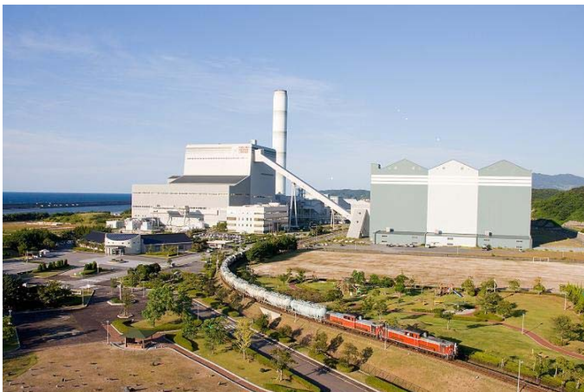
三隅町 三隅発電所と石炭灰を運ぶ貨物車
