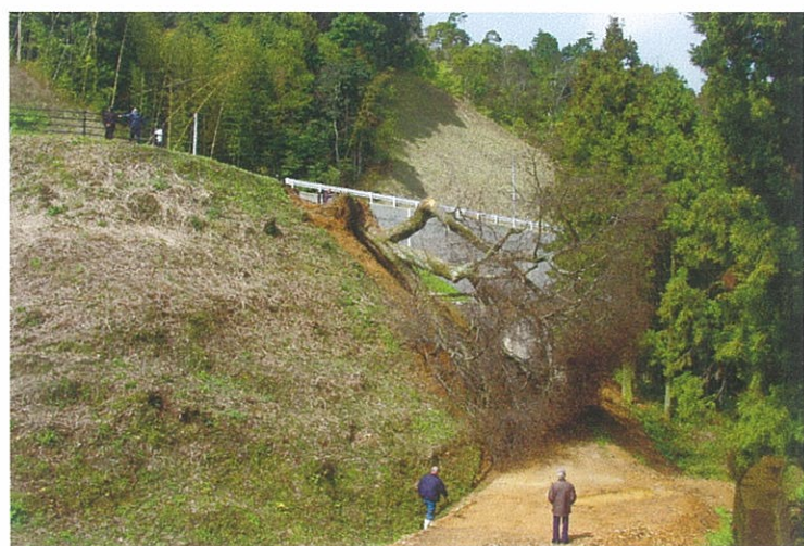
4月1日の倒れた状況
