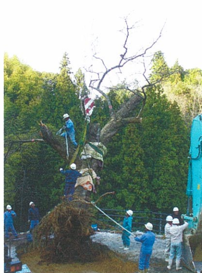
復旧工事状況
