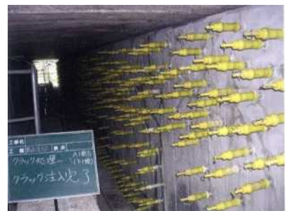
写真 4-2 ひび割れ注入状況
