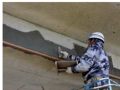
写真 4-3 断面修復状況
