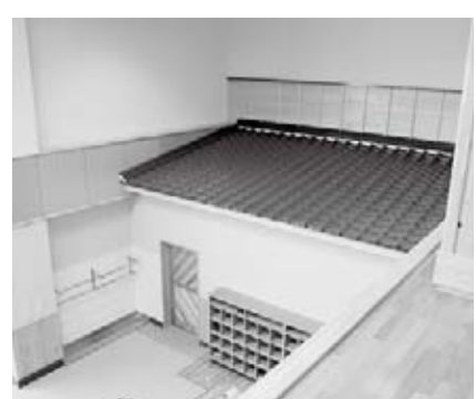
屋内にも石州瓦を使用し、石見らしさを表現した昇降口
