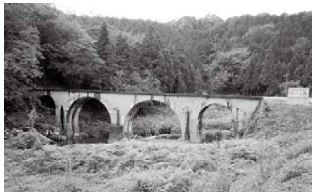
⑧4連アーチ橋 (宇津井町) 土木学会選奨土木遺産に認定されている今福線アーチ橋群の中でもシンボリックなアーチ橋。コンクリートアーチ橋は、太平洋戦争による鉄不足の時代に多用された。
