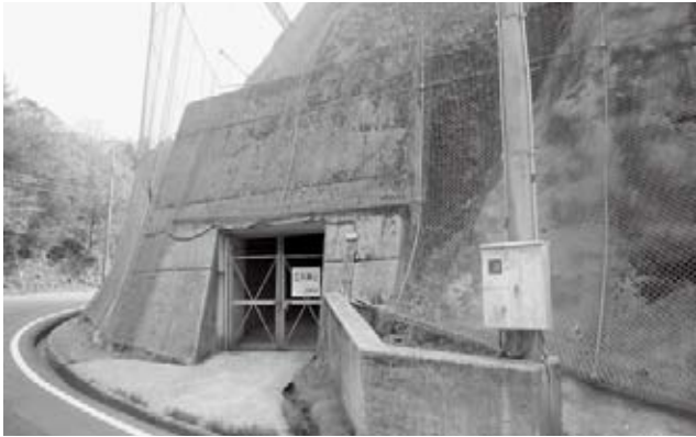
⑩今福第五トンネル（佐野町） このトンネルの中には、横穴を掘ってJR西日本の地震計が設置してある。
