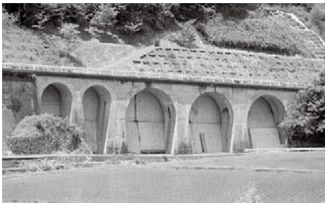
⑥5連アーチ橋 (宇津井町) 現在は県道として使用。橋の下から眺めると、5連アーチ橋奥の山側に擁壁を重ね合わせた構造であることが分かる。
