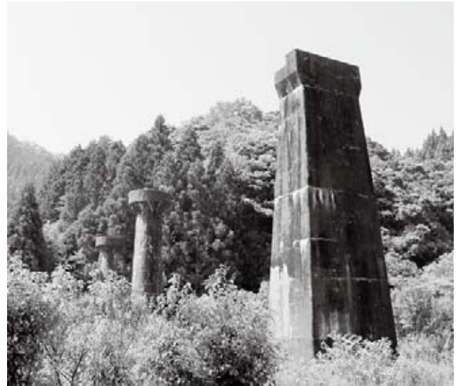
⑤橋脚群（宇津井町） 円形の橋脚は、流水の影響を少なくするためのもの。全国的には舟形や小判形が多く、貴重な遺構。
