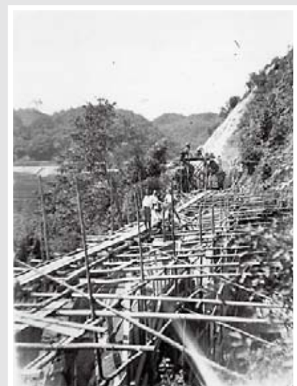
⑪おろち泣き橋工事現場（佐野町）
