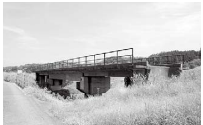
⑯今福橋梁（金城町） 下長屋トンネル（今福坑口側）から現在市道として使われている路盤跡を東に300m進んだ先に残された橋梁。
