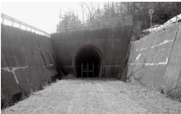
⑮下長屋トンネル（金城町） 新線は、新幹線と直結する主要幹線となるよう、できるだけ直線的に結ぶトンネルを多用した鉄道として計画。このトンネルも全長1,633mで真っ直ぐに建設された。
