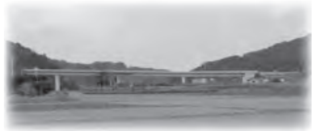
浜田三隅道路 周布川大橋
