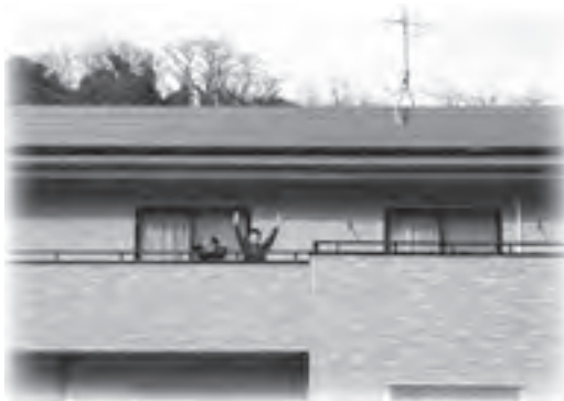
太陽光発電システム
