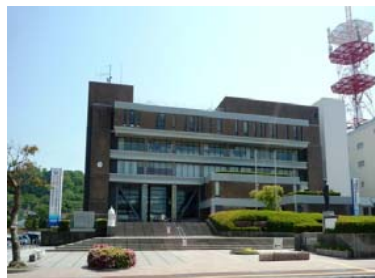
本庁舎耐震改修事業 (事業費5億4,808万円)
