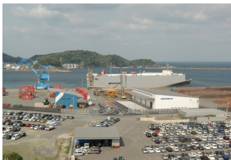
浜田港（福井地区）
