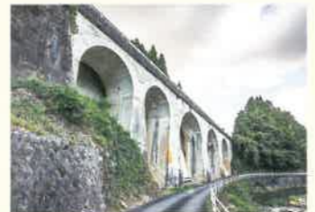
● 5連アーチ橋 現在、県道として使用されています。県道下に降りて眺めると、山側の擁壁と旧線が県道の各片側1車線ずつを構成する面白い構造であることがわかります。石見を象徴するような里山と赤瓦の民家、田んぼがありなす風景も魅力です。
