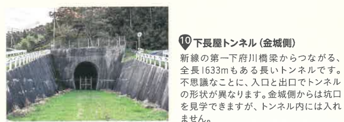
● 下長屋トンネル (金城側) 新線の第一下府川橋梁からつながる、全長1633mもある長いトンネルです。不思議なことに、入口と出口でトンネルの形状が異なります。金城側からは坑口を見学できますが、トンネル内には入れません。
