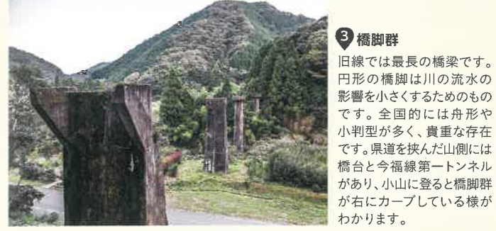
● 橋脚群 旧線では最長の橋梁です。円形の橋脚は川の流水の影響を小さくするためのものです。全国的には舟形や小判型が多く、貴重な存在です。県道を挟んだ山側には橋台と今福線第一トンネルがあり、小山に登ると橋脚群が右にカーブしている様子がわかります。
