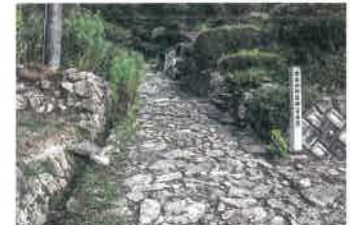
E [佐野地区] 丹後坂の石畳 江戸時代、浜田藩主の一行が参勤交代の時に、この丹後坂を通り広島へ向かいました。雨水で路面が崩れないよう、坂に石を敷き詰め流失を防いだのは当時の人の知恵でしょう。
