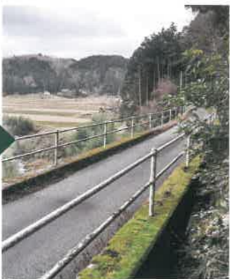
おろち泣き橋 (現在) 現在は市道に転用されており、橋の両側に落下防止のための手すりが施されています。田園風景は今も変わりません。
