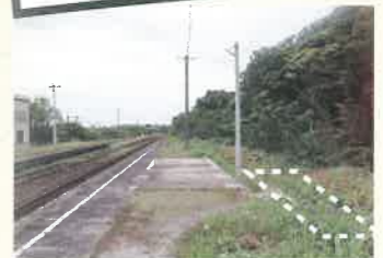
● JR下府駅「幻の3番線」 左側2番のりばのさらに右側(幻の3番線)に今福線旧線が入り、右の小山に向けて橋台や路盤が建設されました。現在、3番線は空地となっています。
