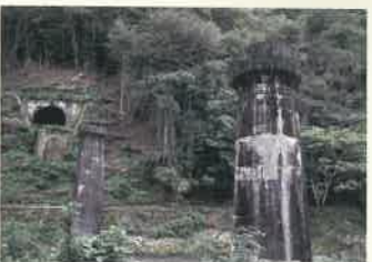
● 有福第三トンネルと橋脚 県道の桜並木を過ぎると突然遺構が現れます。対岸のトンネル坑口と橋脚のつながりに未成線の無念さを感じさせます。見学の際は車両の通行にご注意ください。
