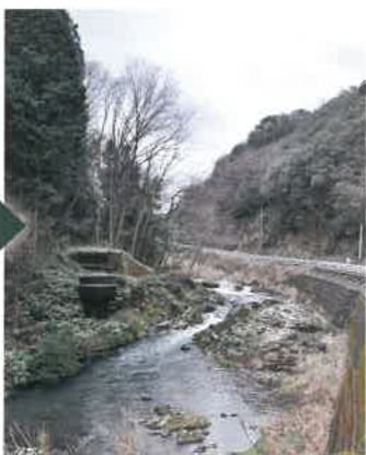
今福第五トンネル付近 (現在) 手前の橋脚は失われており、今は水面付近に土台跡と鉄筋がわずかに残っています。路盤跡は木々に覆われています。
