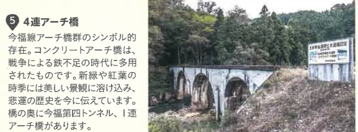
● 4連アーチ橋 今福線アーチ橋群のシンボリック的存在。コンクリートアーチ橋は、戦争による鉄不足の時代に多用されたものです。新線や紅葉の時期には美しい景観に溶け込み、悲運の歴史を今に伝えています。橋の奥に今福第四トンネル、1連アーチ橋があります。
