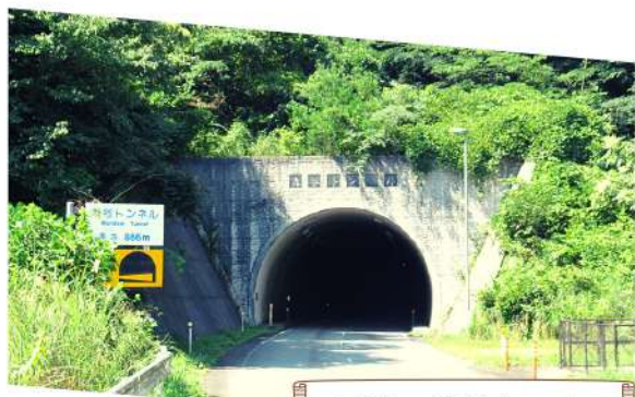
現在の森谷トンネル
