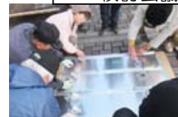
組立・設置作業
