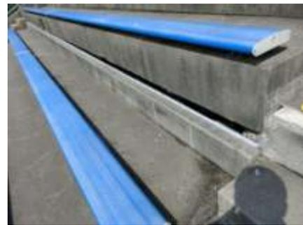
地盤沈下の進行や施設の老朽化を原因とする設備の破損（メインスタンド）
