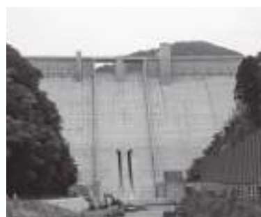
第二浜田ダム
