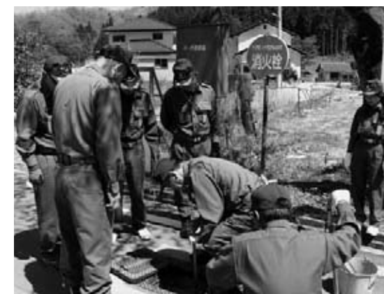
消火栓の取扱いや注意点を確認し合う団員
