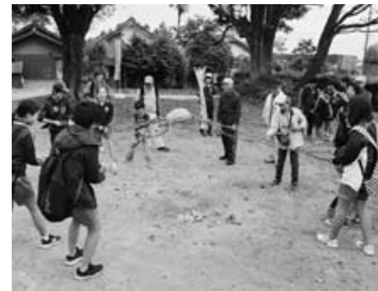
罫縄を引っ張り石を持ち上げ落として土を固める
