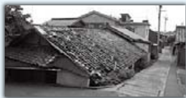
危険な空き家
