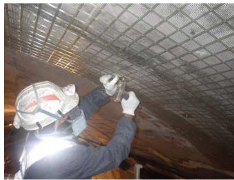
写真 4-1 FRP ネット設置状況
