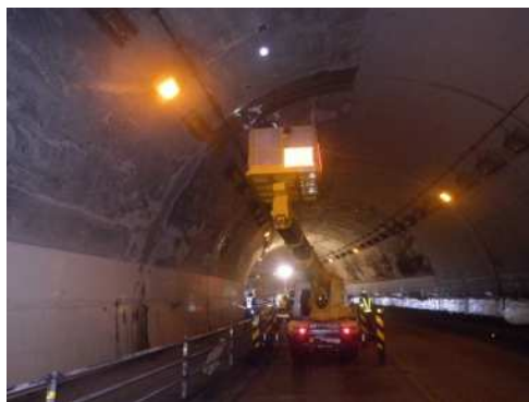
写真 4-1 FRP ネット設置状況
