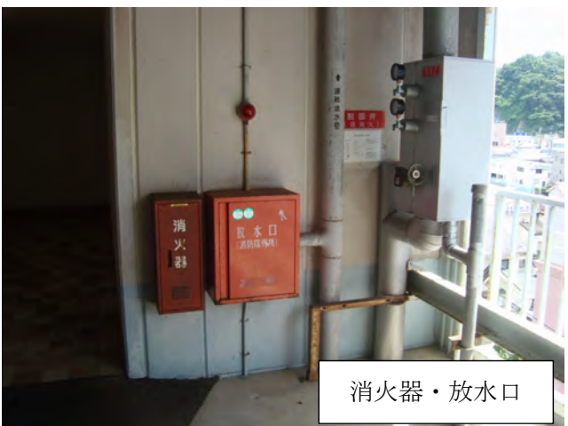
屋上消火器・移動式粉末消火設備
