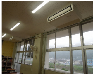
普通教室エアコン整備事業
