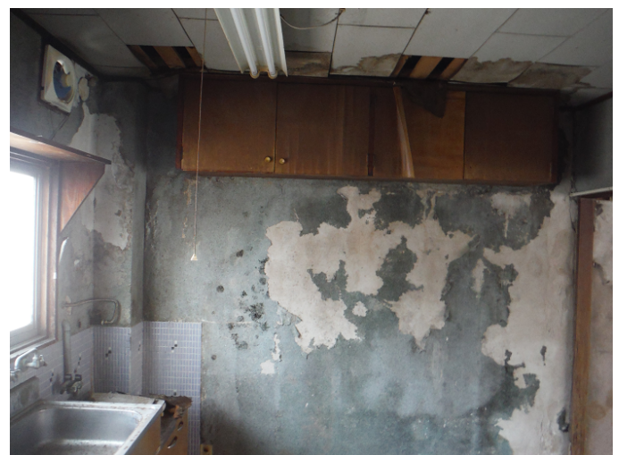
内観写真 （2階居宅）
