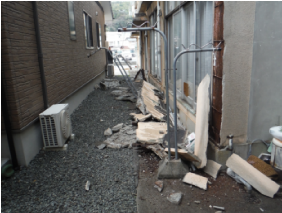
軒裏・外壁モルタル落下状況の写真(H31.1.28撮影)
