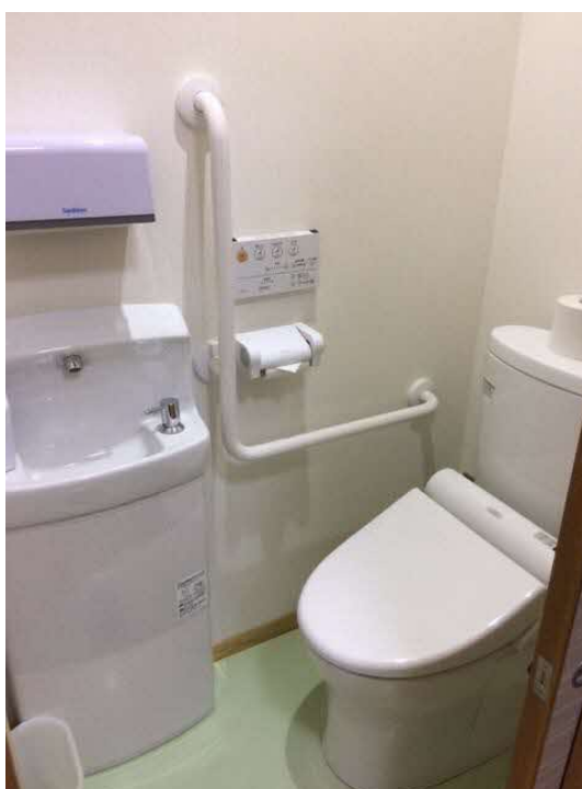
⑪男子脱衣室トイレ
