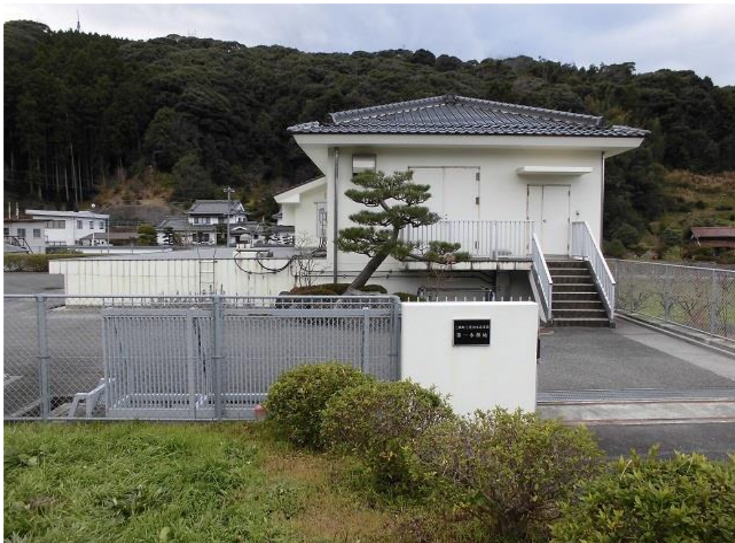
浜田市工業用水道事業 第1水源地
