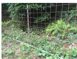
地際をパイプで固定
