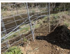
イノシシによって破損した柵
