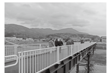
周布橋仮設歩道橋
