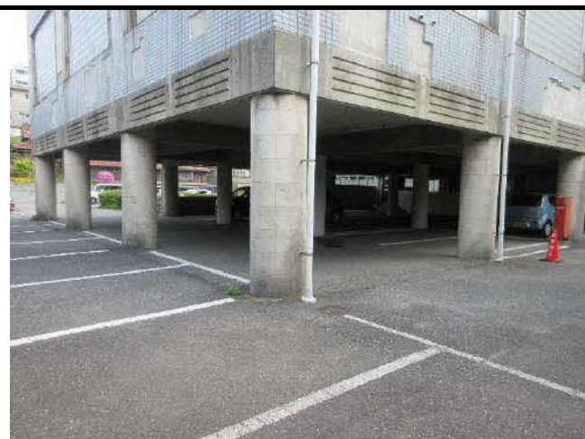
温水プール階下の駐車場
