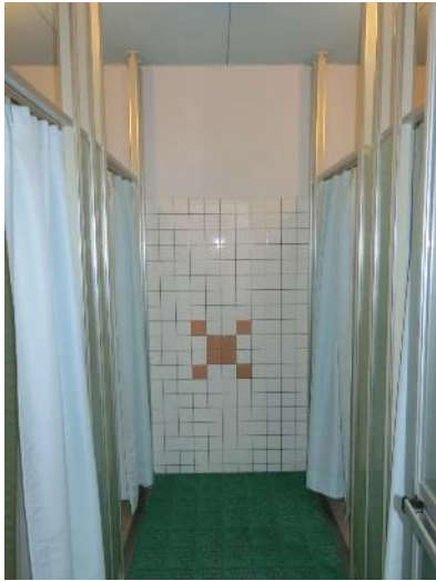
B 競技場_シャワー室(4室)
