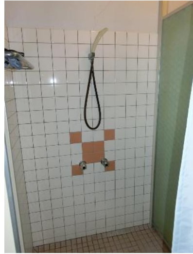
B 競技場_シャワー室内部
