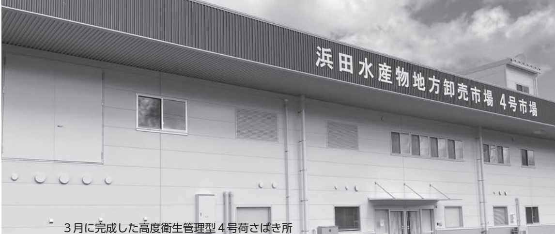
3月に完成した高度衛生管理型4号荷さばき所
