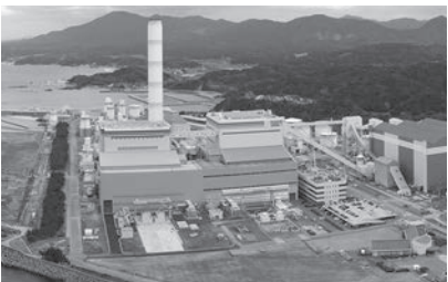
中国電力三隅発電所 (1号機、2号機)
